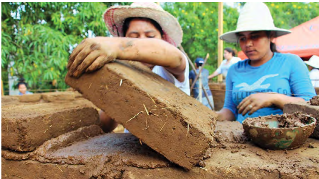
AMCC, 2015 Mujeres construyendo con adobe durante el taller de construcción con tierra.
